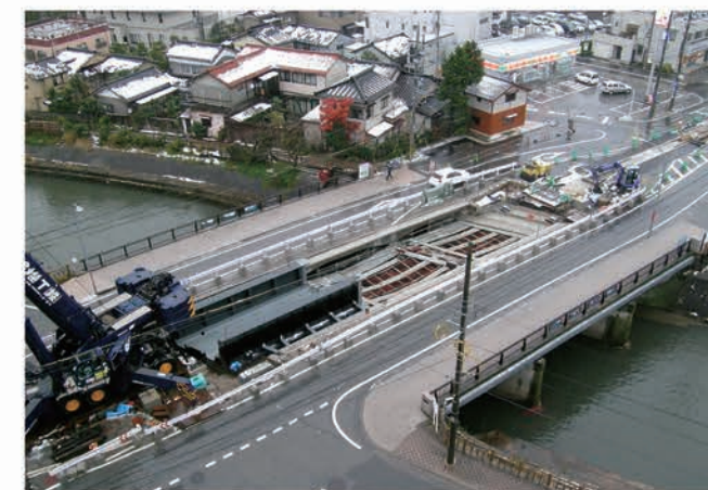
八田橋軌道部架替工事
